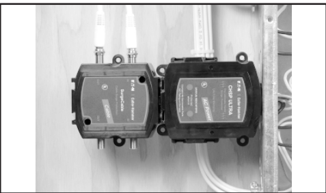
Figure 7. Joining CHSP Modules/Conexión de los módulos CHSP (1)/Jonction de modules CHSP (1/)
