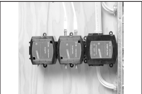
Figure 10. Joining CHSP Modules (4)/Conexión de los módulos CHSP (4)/Jonction de modules CHSP (4)
