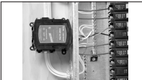
Figure 2. Panel Mount Installation (2)/Instalación en el centro de carga (2)/Installation au panneau (2)
