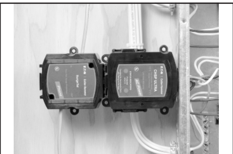
Figure 8. Joining CHSP Modules (2)/Conexión de los módulos CHSP (2)/Jonction de modules CHSP (2)
