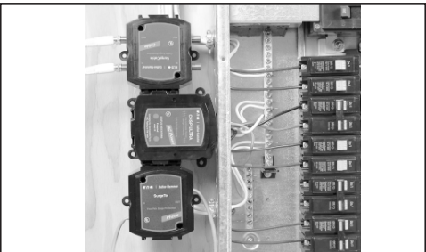
Figure 9. Joining CHSP Modules (3)/Conexión de los módulos CHSP (3)/Jonction de modules CHSP (3)
