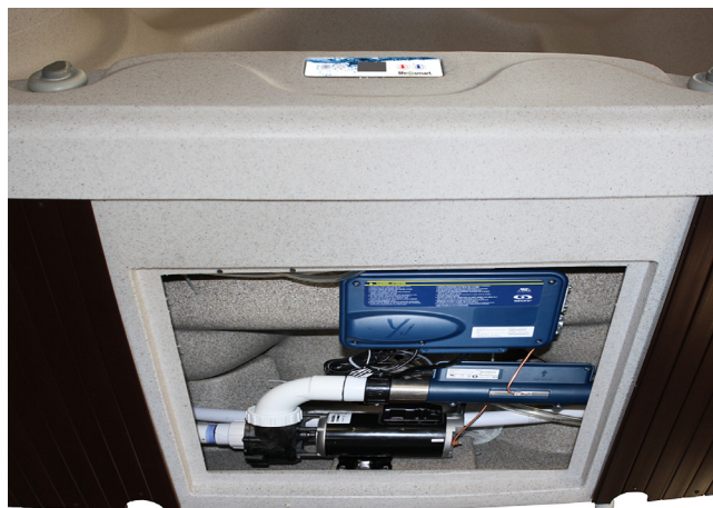
Le panneau d'accès à l'équipement est situé en dessous du panneau de commandes supérieur sur les spas LifeSmart de 230 volts.
