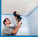
SPRAY-ON with Hopper Style Spray Gun Aeross escaldado con el arma de aerosol del estilo de la tolva
