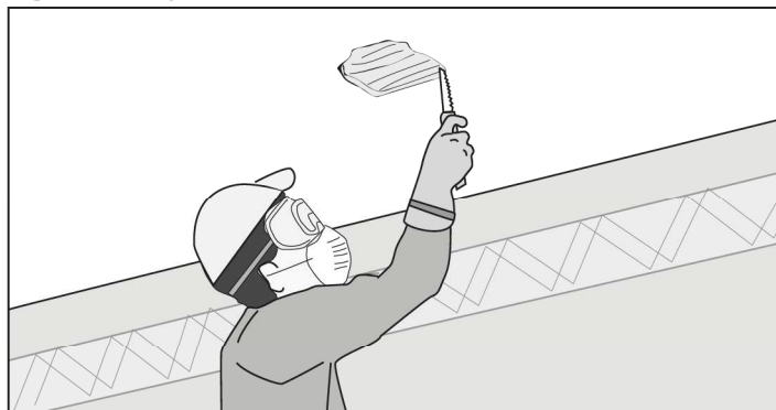
Fig.6. Agrande el orificio preliminar hasta que pueda ver una viga.
