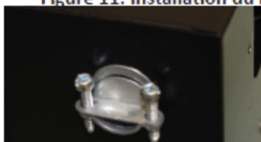
Figure 11: Installation du raccord de câble sur le radiateur
