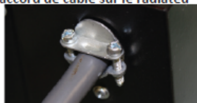
Figure 11: Installation du raccord de câble sur le radiateur
