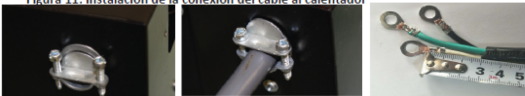
Figura 11: Instalación de la conexión del cable al calentador
