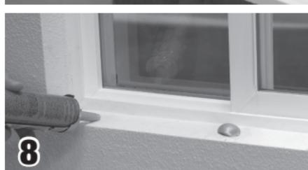
**8** Coloque esferas de 1 pulgada de adhesivo de poliuretano para construcción a 6 pulgadas de cada extremo y a 12 pulgadas en el centro del área del alféizar.
