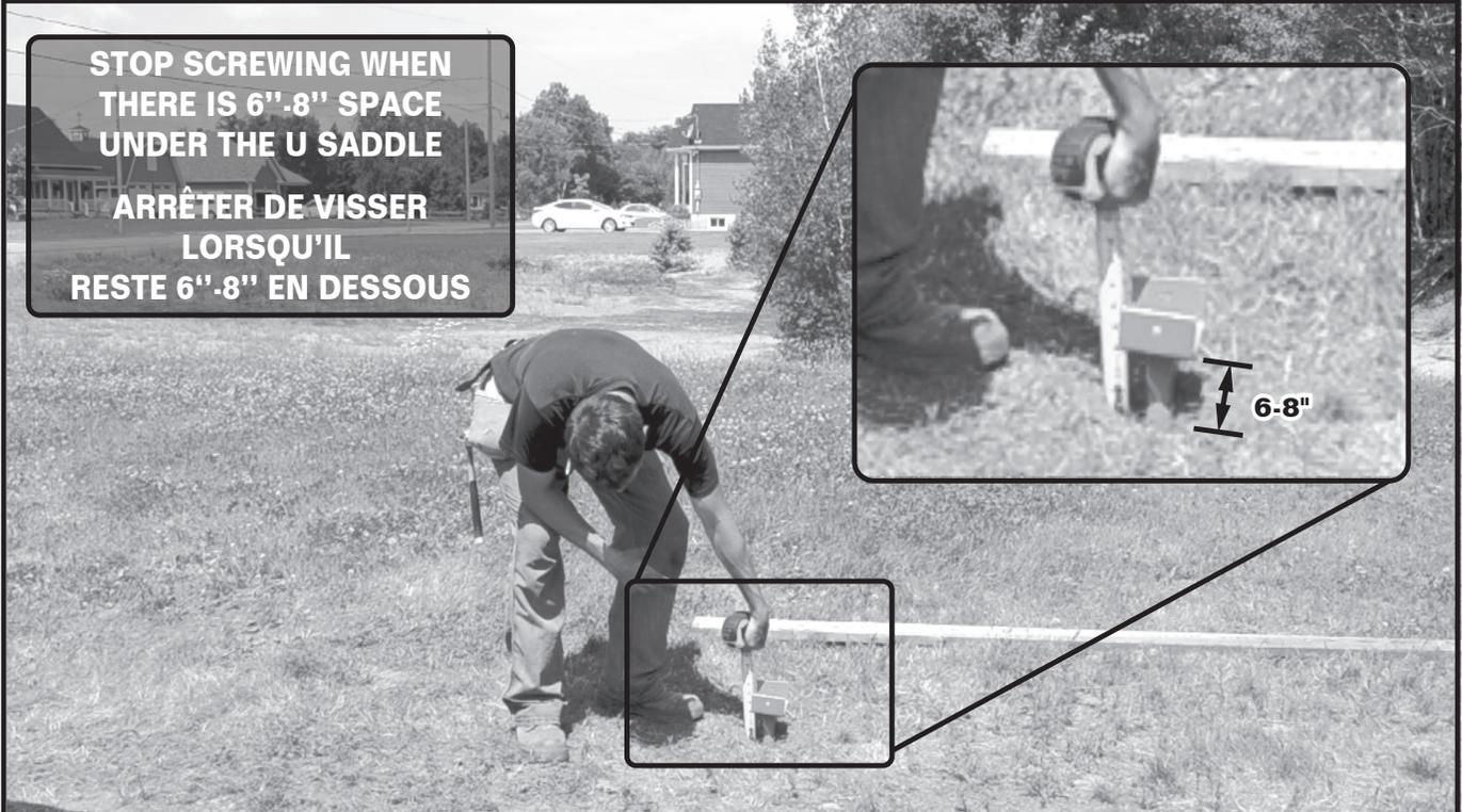
**WHEN 6-8" LEFT TO SCREW IN, USE THE SLEDGEHAMMER TO COMPACT THE GROUND UNDER THE 6" DISK OF THE ADJUSTABLE PYLEX 50"**
