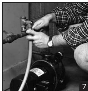
de la manguera plástica de 1/2". Enrosque el conjunto del conector de la manguera en la válvula de alivio. Ajústelo con la llave inglesa.
