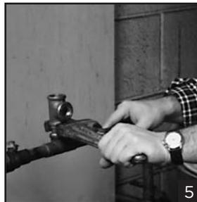
Pointez l'ouverture qui se trouve sur le côté du T vers l'avant ou vers le côté afin qu'il soit facilement accessible. (Fig. 5)
