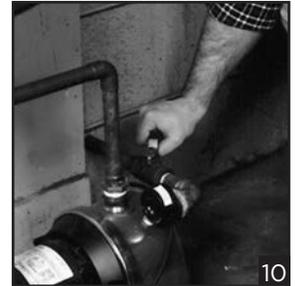
Lors de l'expédition à partir de l'usine, les modèles HT2B, HT4B et HT8B sont préchargés avec 38 psi. Si cette charge est trop élevée, laissez échapper un peu d'air en appuyant sur la broche à l'intérieur du robinet d'admission d'air. Si la charge n'est pas suffisamment élevée, pompez-la avec une pompe pour pneus de bicyclette.
