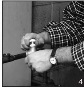
c. Installez l'autre extrémité du mamelon simple en l'insérant dans l'ouverture du filetage femelle de la conduite d'alimentation de la pompe, où l'ancien réservoir était installé. (Le mamelon simple a maintenant un T pour tuyau pointé directement vers le haut.) Serrez le T 3/4 de tour avec une clé à tuyau, puis manuellement.
