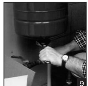
c. Enlevez le capuchon de plastique du robinet d'admission d'air sur le dessus du réservoir. Avec le manomètre à pneus, vérifiez la charge d'air du réservoir.
