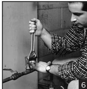
8. Fixez un tuyau ou un boyau pour éloigner le trop-plein de secours des raccordements électriques de la pompe, si nécessaire. **N'installez pas une prise ou une soupape, et n'insérez pas quoi que ce soit d'autre à l'intérieur de la soupape de surpression qui pourrait obstruer le débit d'eau. Cela peut présenter un risque significatif pour la sécurité à l'intérieur de votre maison.**
