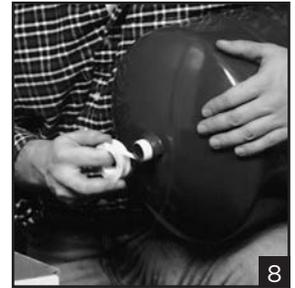
b. Installez le nouveau réservoir dans l'ouverture du filetage femelle du T pour tuyau. Tournez manuellement. Bien serrez avec la clé ajustable de 30,48 cm (12 po) sur la connexion hexagonale au bas du réservoir. (Fig. 9)
