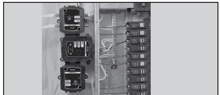
Figure 9. Joining CHSP Modules (3)/Joncción de módulos CHSP (3)/Conexión de los módulos CHSP (3)
