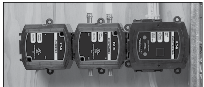
Figure 10. Joining CHSP Modules (4)/Joncción de módulos CHSP (4)/Conexión de los módulos CHSP (4)
