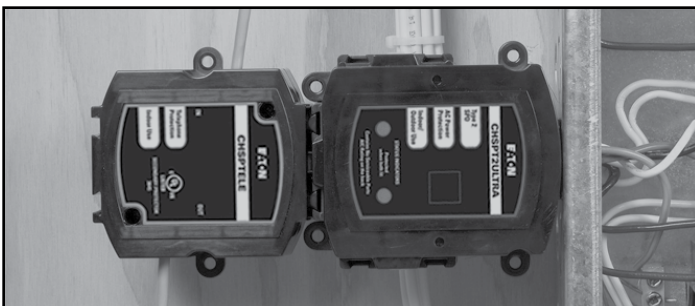
Figure 8. Joining CHSP Modules (2)/Joncción de módulos CHSP (2)/Conexión de los módulos CHSP (2)
