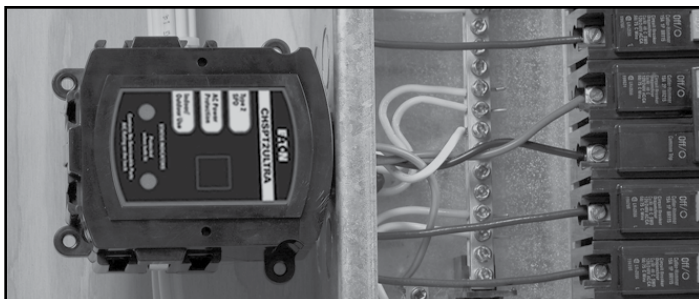
Figure 2. Panel Mount Installation (2)/Installation au panneau (2) (2)/Instalación en el centro de carga
