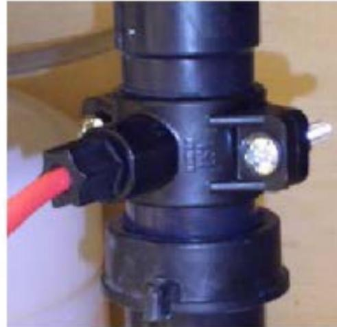
**Fig. 5 Abrazadera para drenaje**
