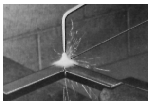
Figura 18. Soldadura con latón
