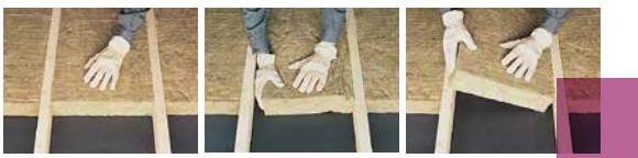
Se corta con rapidez y precisión con un cuchillo serrado, como los cuchillos de pan, de modo que puede lograr un ajuste óptimo para elrededor de tuberías, cañas de electricidad, cables, ductos y entre los listones y vigas que tengan un ancho que no sea estandar.
