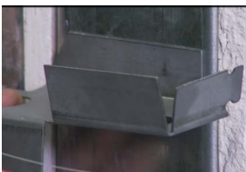
Steel stud anchor
