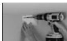
**Opción #1-** Utilizando bloques de esquina de Focal Point: taladre un hoyo de 3/16" de diámetro en el centro de cada lengüeta de los bloques. Instale los bloques de esquina en cada esquina y los bloques conectores en el centro de cada pared. Instale los bloques antes de instalar los "Quick Clips". Utilice pegamento de poliuretano entre las molduras y bloques conectores.
