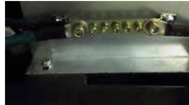
Generator Grounding Bar Lug
